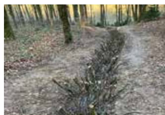
Stabilisation des ravines d'érosion en forêt.
