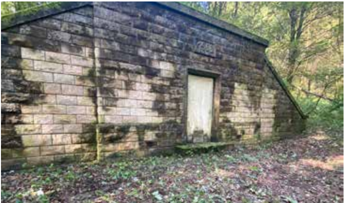
Réservoir d'eau « Am Léin » après les travaux
