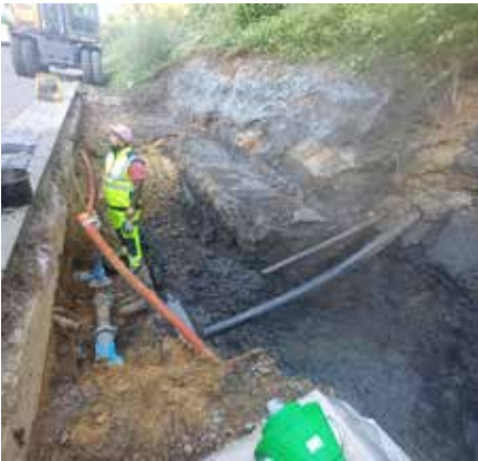
Ancienne conduite d'eau potable dans la rue de Mamer
