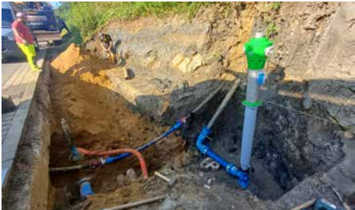
Nouvelle conduite d'eau avec un hydrant hors sol
