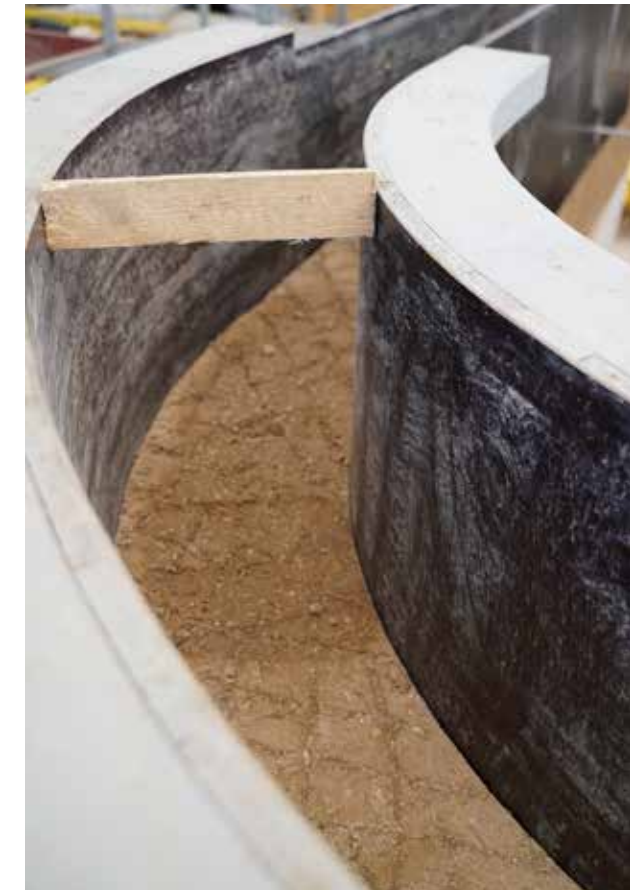
Pisé - matériel utilisé dans la construction de la nouvelle morgue
